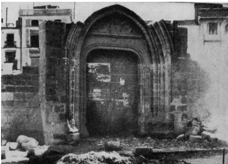
Ilustración 12. Estado en que quedó la Iglesia Mayor de Castellón. Monumento nacional
